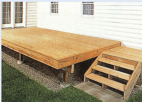
5 계단설치 - 계단철물시공 (TA9, TA10)
