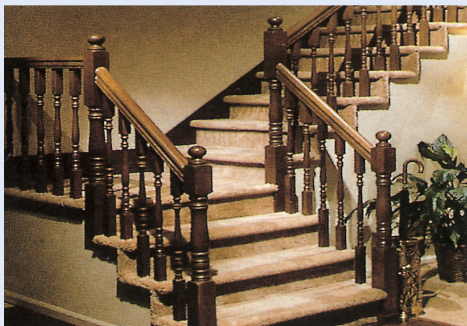
미송 집성 계단에 Stain 시공
